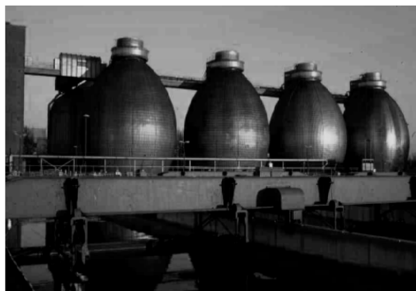
Рис. 2. Метантенк яйцевидной формы (Германия)
