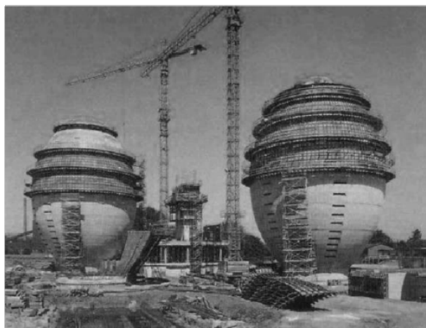
Рис. 1. Строительство метантенка яйцевидной формы (Германия)
