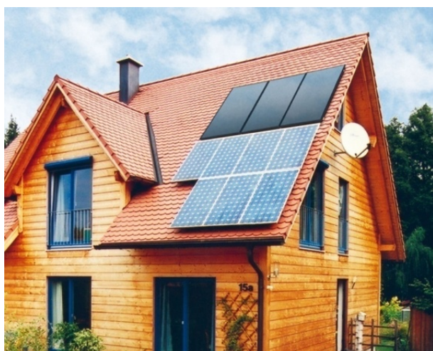
Рис. 2. Установка солнечных батарей на крыше частного дома
