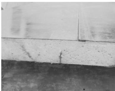
Рис. 5. Фрагмент многослойной панели в зоне стыковки обшивок
