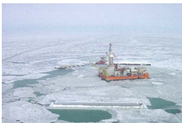
Рис. 2. Нефтегазодобывающая платформа в условиях ледяного покрова
