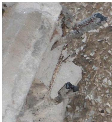
Рис. 5. Арматурные выпуски для соединения наружных стеновых панелей
